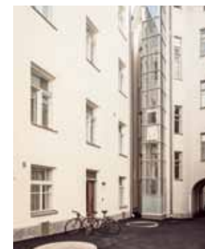
WINDA ZAINSTALOWANA W ZEWNĘTRZNYM SZYBIE
