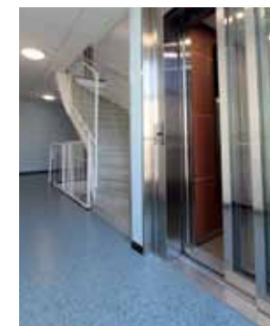
WINDA ZAINSTALOWANA OBOK SCHODÓW
