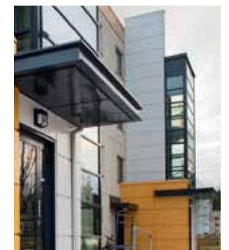
WINDA ZAINSTALOWANA WEWNĄTRZ BUDYNKU, SCHODY DOBUDOWANE NA ZEWNĄTRZ
