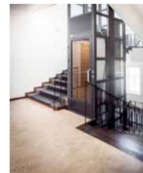
WINDA ZAINSTALOWANA W DUSZY KLATKI SCHODOWEJ
